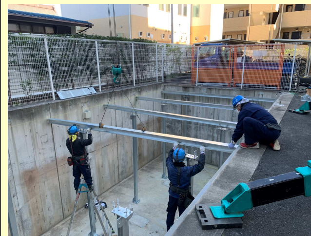
柱・縦梁：組立
