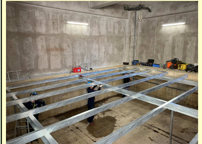
縦梁・横梁：組立
