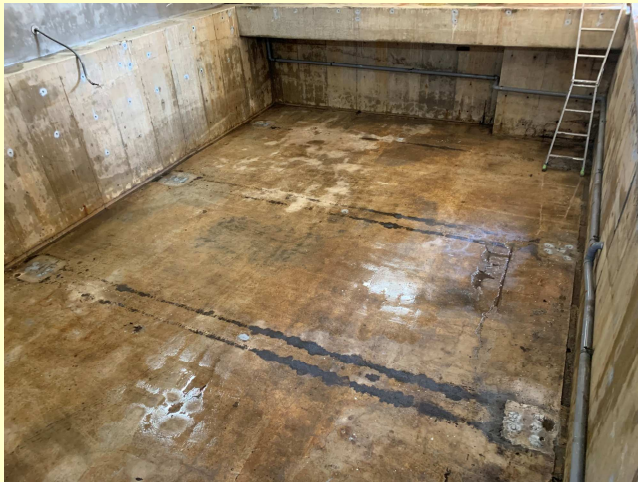
既設立駐機：解体撤去完了
