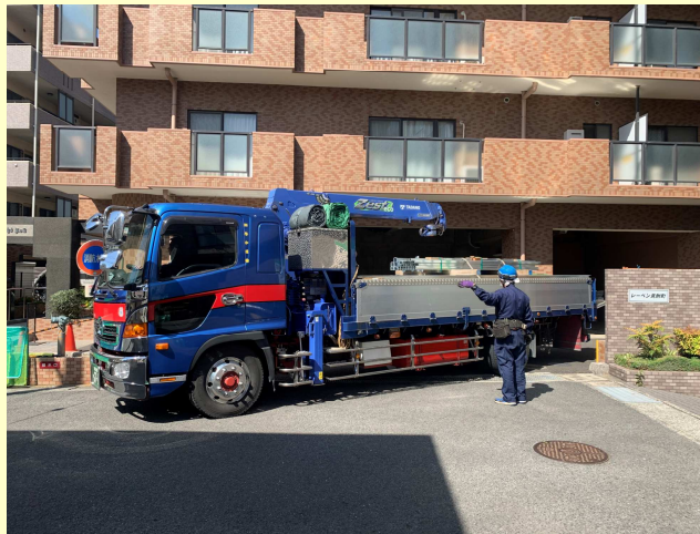
鋼製平面化部材：搬入
