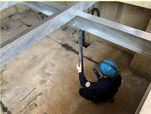
柱ベースジャッキ：据付
