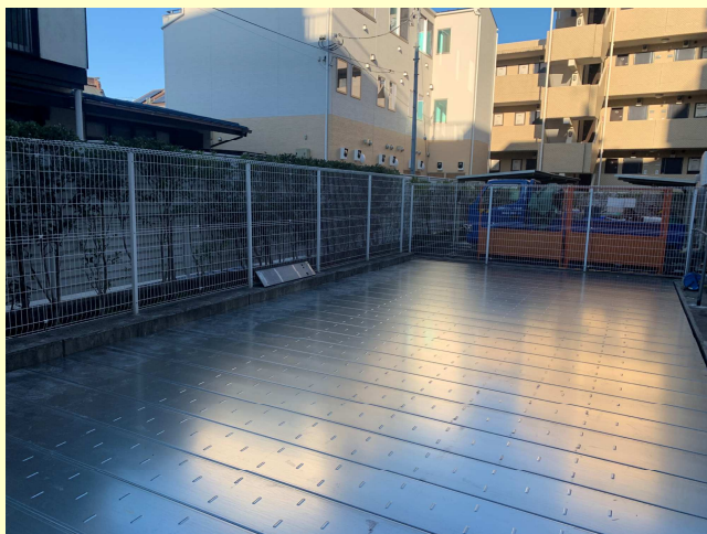
床板：据付完了
