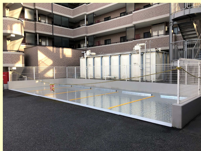
ロープ養生・立入禁止
