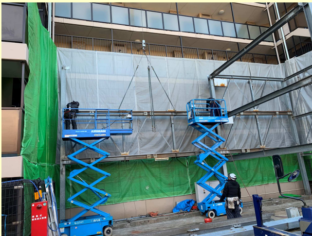
施工時：高所作業車(2台)
