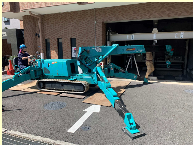
施工時：2.9tカニクレーン
