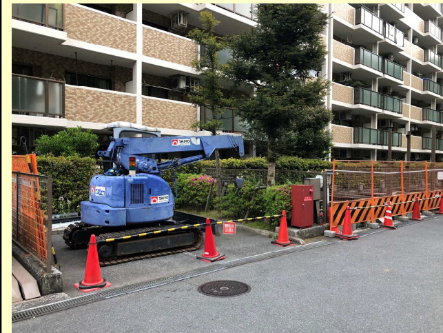
クローラークレーン
