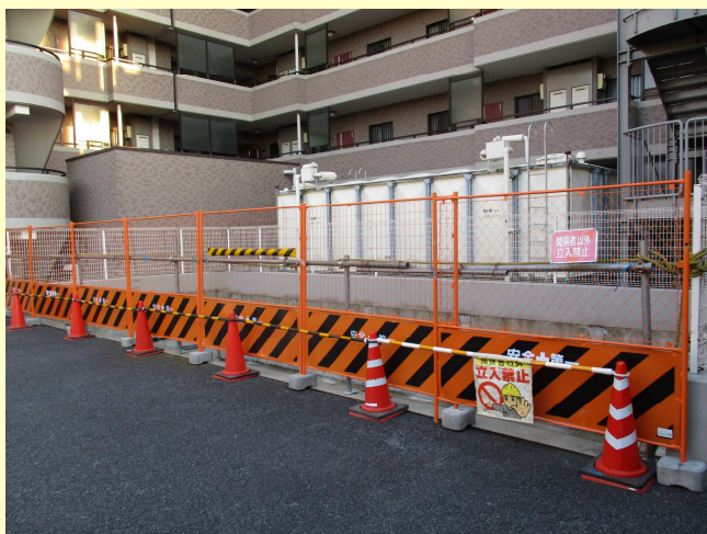
B型バリケード・単管設置
