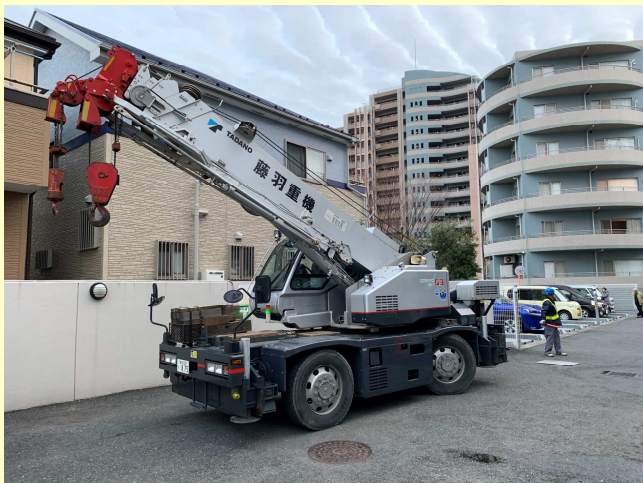
13tラフタークレーン
