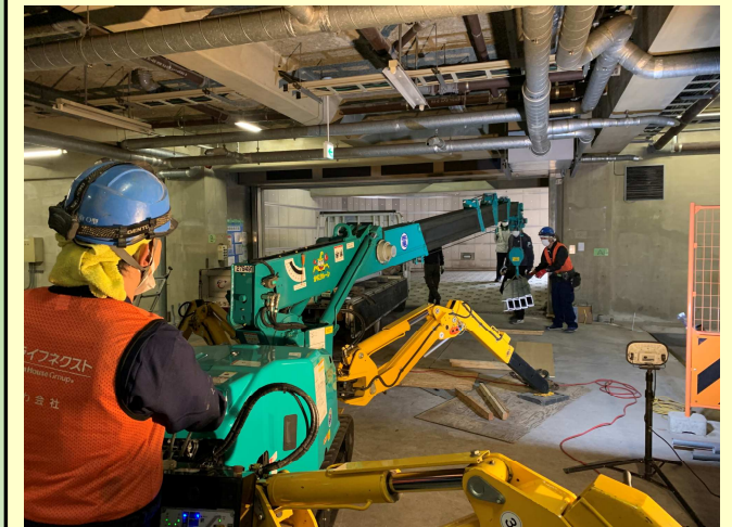
施工時：2.9tカニクレーン
