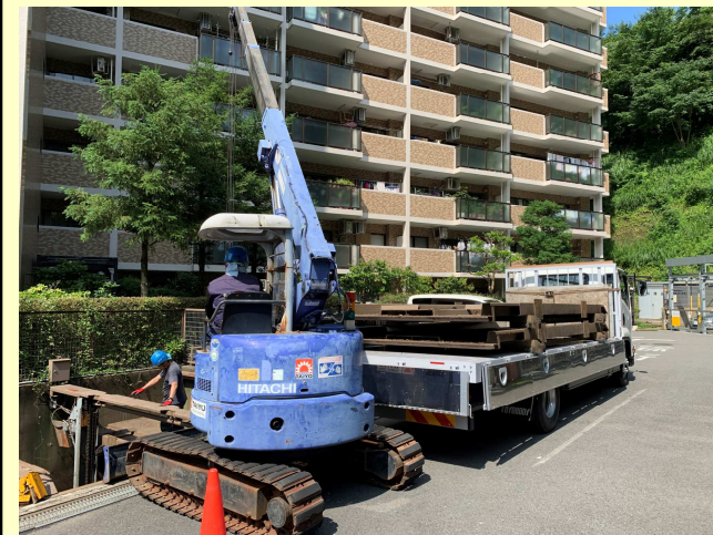
施工時：クローラークレーン
