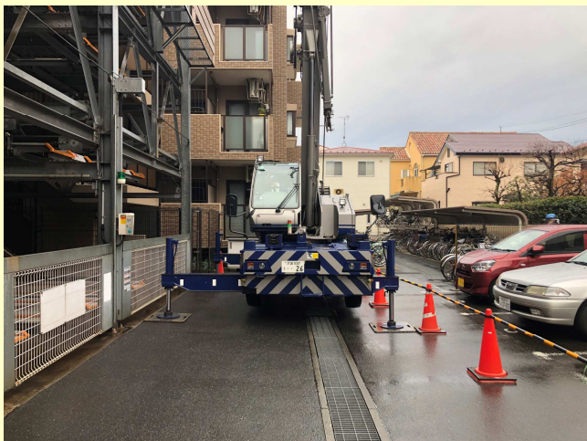
施工時：13tラフタークレーン
