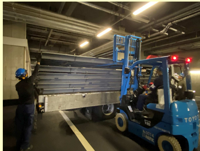
施工時：2tフォークリフト
