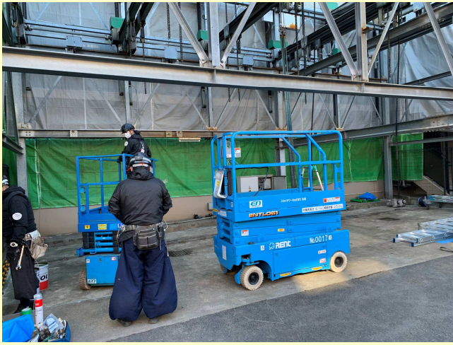
高所作業車(2台)
